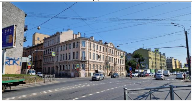
Фото 10. Вид здания расположения Объекта оценки
