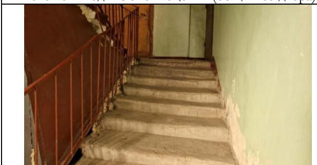
Фото 17. Лестница Объекта оценки
