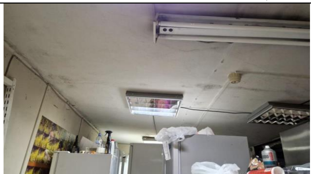
Фото 26. Типичное состояние Объекта оценки
